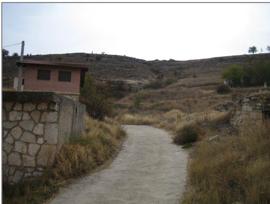
Fotografía A-3. Torrera de evacuación de aguas pluviales desde el páramo.
